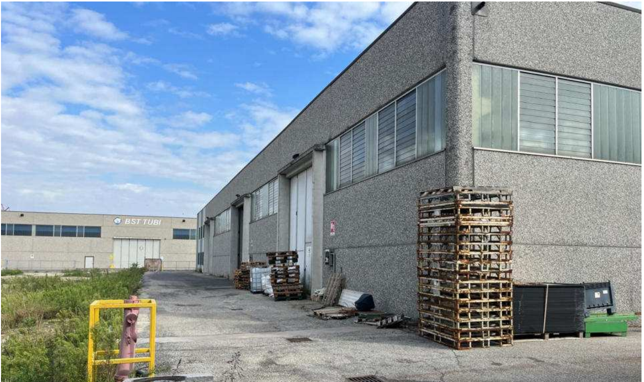
Prospetto Ovest fabbricato B - Fronte oggetto dell'ampliamento
