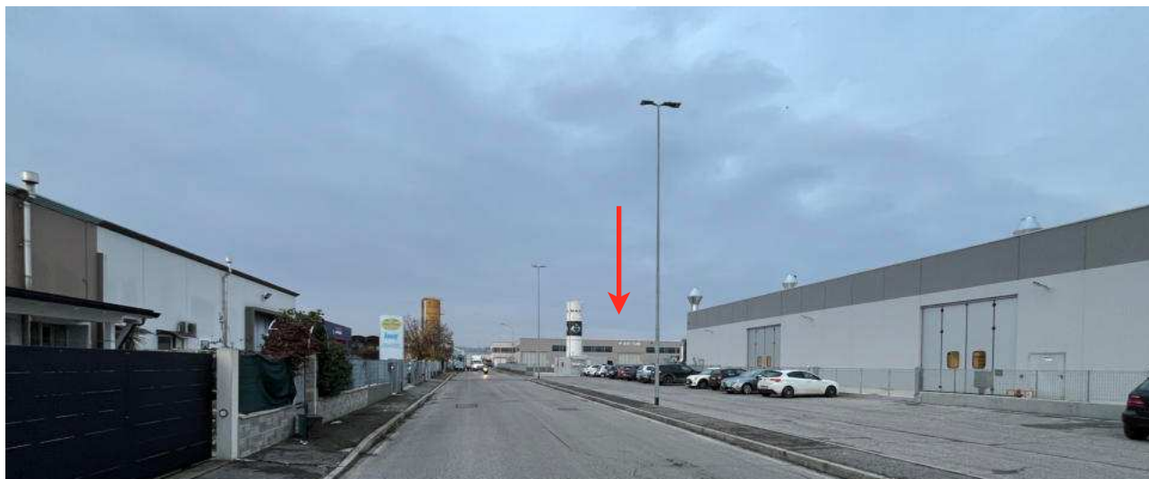
Vista da Sud, da Via VIII Marzo
